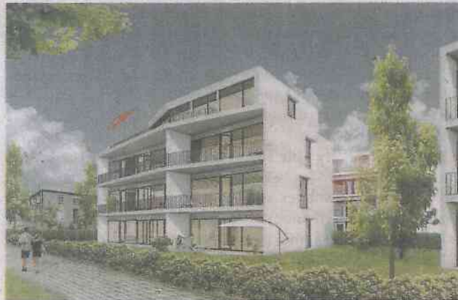
Das Wohngebiet: Vier Mehrfamilienhäuser sind neben den begonnenen Stadthäusern am Lenkwerk geplant. ENTWURF: JONEK & DRESSLER
